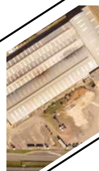
CENTRO DE DISTRIBUIÇÃO CAPIVARI DE BAIXO/SC
